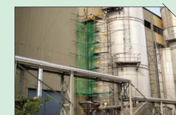
● 배열회수보일러 추가 폐열회수설비 설치
