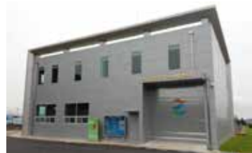
▲ 소수력 발전시설 (광주덕남정수장)
