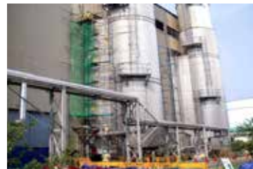
▲ 배열회수보일러 추가 폐열회수설비 설치
