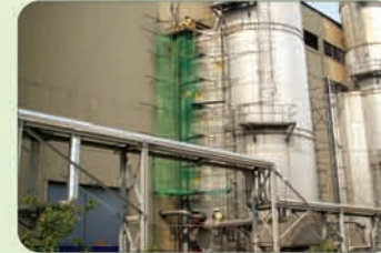
■ 배열회수보일러 추가 폐열회수설비 설치
