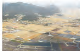
▲ 풍력 발전시설 (영광약수 풍력 EPC)
