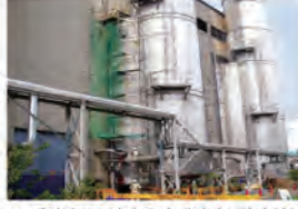
▲ 배열회수보일러 추가 폐열회수설비 설치
