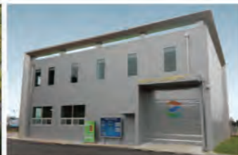
▲ 소수력 발전시설 (광주덕남정수장)
