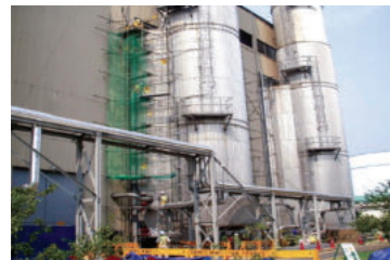
▲ 배열회수보일러 추가 폐열회수설비 설치
