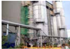
▲ 배열회수보일러 추가 폐열회수설비 설치
