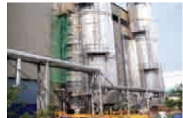
▲ 배열회수보일러 추가 폐열회수설비 설치
