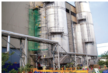
▲ 배열회수보일러 추가 폐열회수설비 설치
