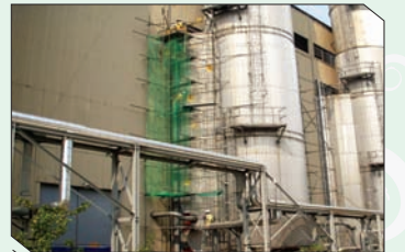
배열회수보일러 추가 폐열회수설비 설치
