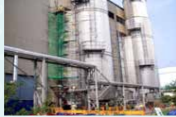
▲ 배열회수보일러 추가 폐열회수설비 설치
