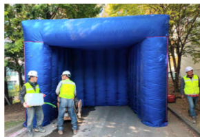
이동식 방음판넬 설치 (열배관시설 공사장)
