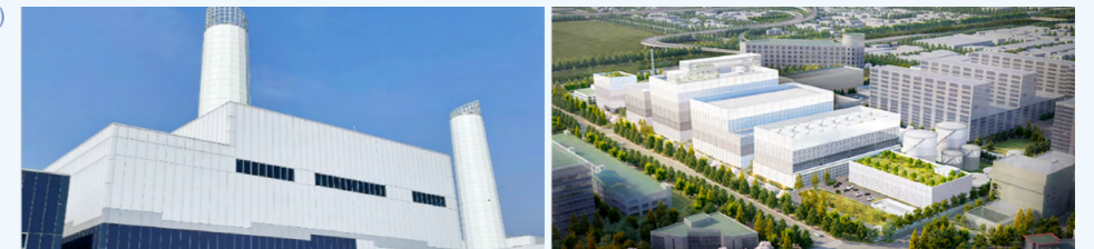
좌) 안양 열병합발전소(2021년 12월 준공) 우) 부천 열병합발전소(현대화 조감도)
