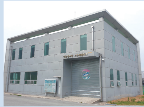
소수력 발전시설 (광주덕남정수장)
