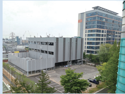
연료전지 발전시설 (부천열병합발전소)
