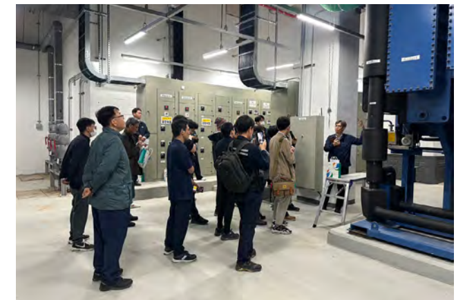
설비 앞 현장 설명 장면
